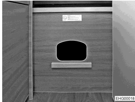
Fig. 6 Cloison de séparation
