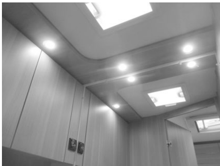
Fig. 73: Illuminazione bagno, esempio
