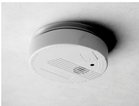
Fig. 52: Rivelatore di fumo
