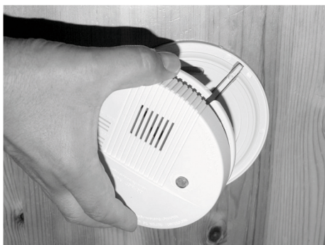
Fig. 114: Togliere l'alloggiamento
