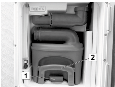
Fig. 154: Serbatoio acque nere nel vano WC
