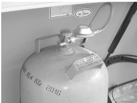
Fig. 107: Bombola di gas con valvola riduttrice di pressione
