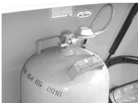
Fig. 73: Bombola di gas con pressostato di bassa pressione e tubo flessibile per bassa pressione
