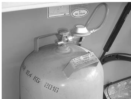
Fig. 106: Bombola di gas con valvola riduttrice di pressione
