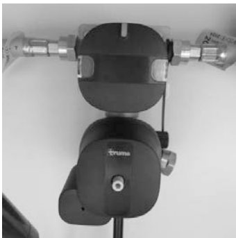
Fig. 107: Alimentazione del gas DuoControl CS
