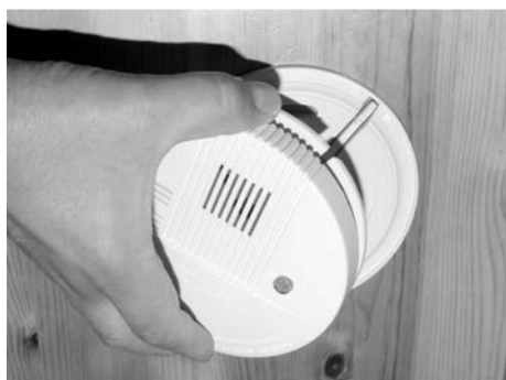
Fig. 202: Togliere l'alloggiamento
