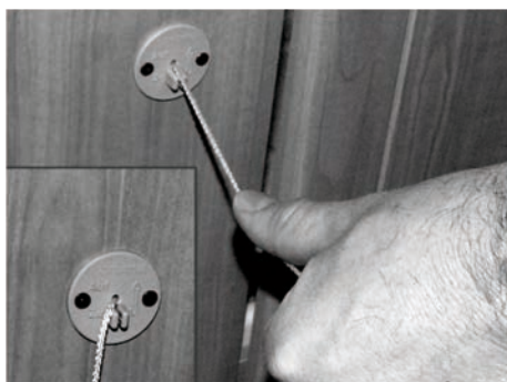
Fig. 79: Valvola di blocco
