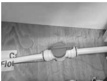
Fig. 91: valvola riscaldamento a pavimento ALDE
