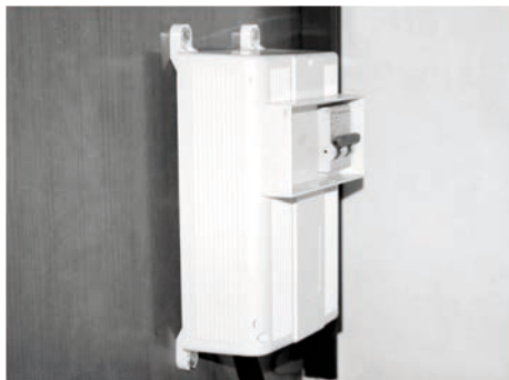
Fig. 61: Interruttore principale (interruttore differenziale FI)
